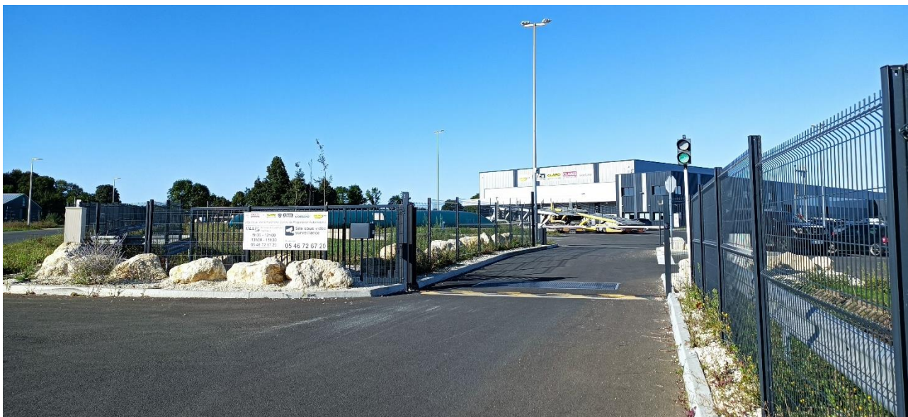
Photo 6 : Entrée de la plateforme de préparation
