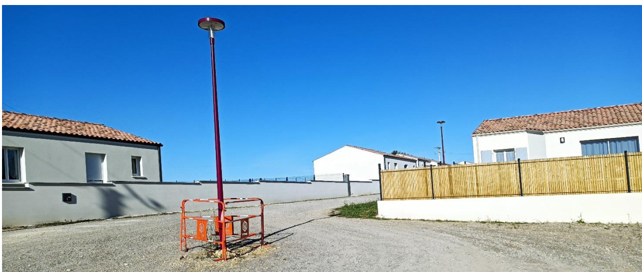
Photo 11 : Lotissement en cours d'aménagement au Nord de la zone d'étude
