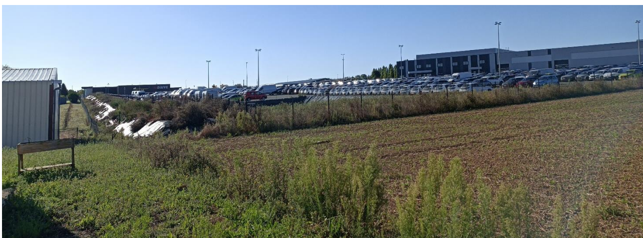
Photo 12 : Vue sur l'angle Nord-Ouest face au bassin de temporisation pour gestion des eaux
