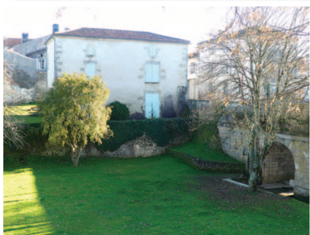
Travaux de réhabilitation de la Maison Marie Bon / Pierre Loti
